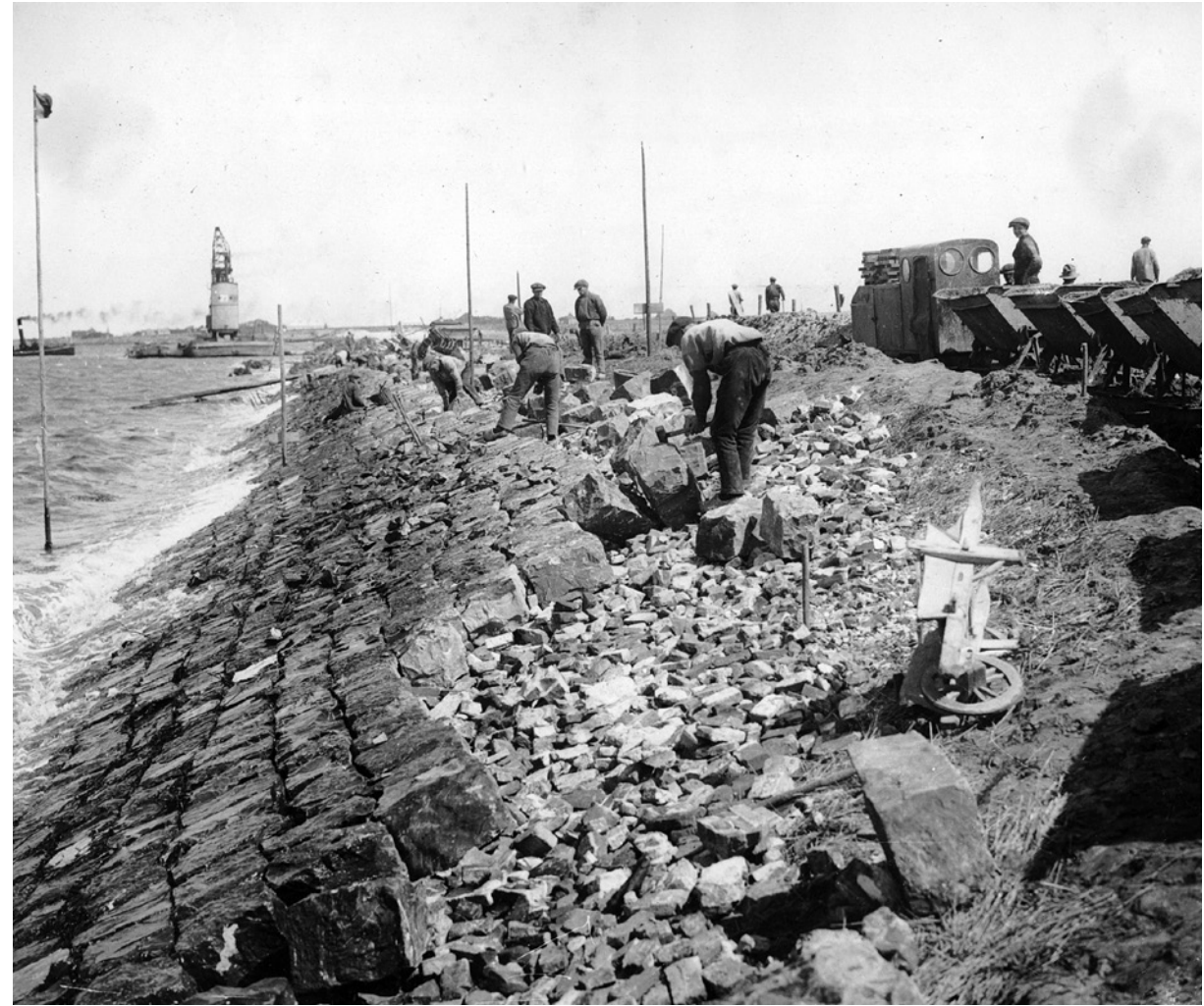
Aanleg van de afsluitdijk, 1932 (Beeldbank Rijkswaterstaat)
